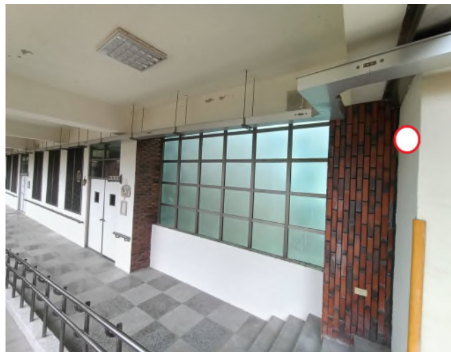
編號 6 實習大樓三樓工藝教室前門樑角落
