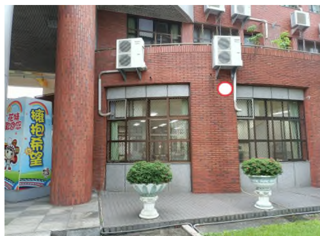
編號 2 行政大樓穿堂左側牆面
