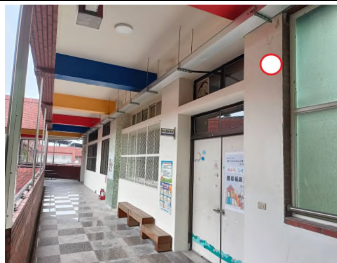
編號 4 教學大樓三樓樂活教室前門上方
