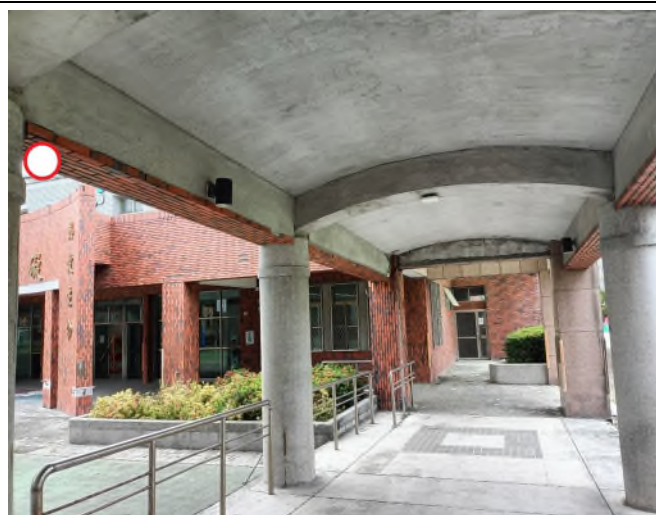
編號 10 風雨走廊(體育館和操場中間)
