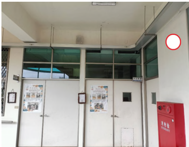
編號 5 實習大樓三樓校史室牆面
